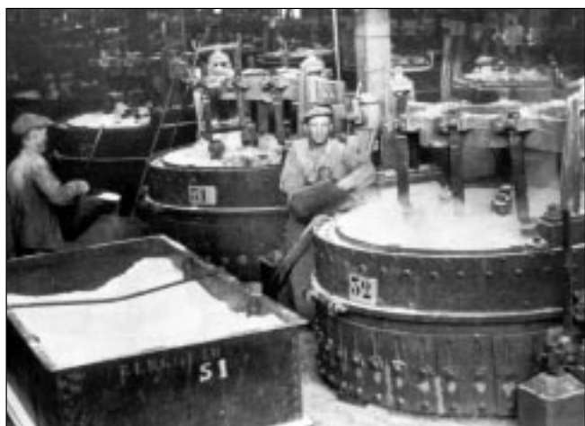
Les fours d'électrolyse des halles 5-6 de l'usine de Chippis, avant la Seconde Guerre mondiale.
